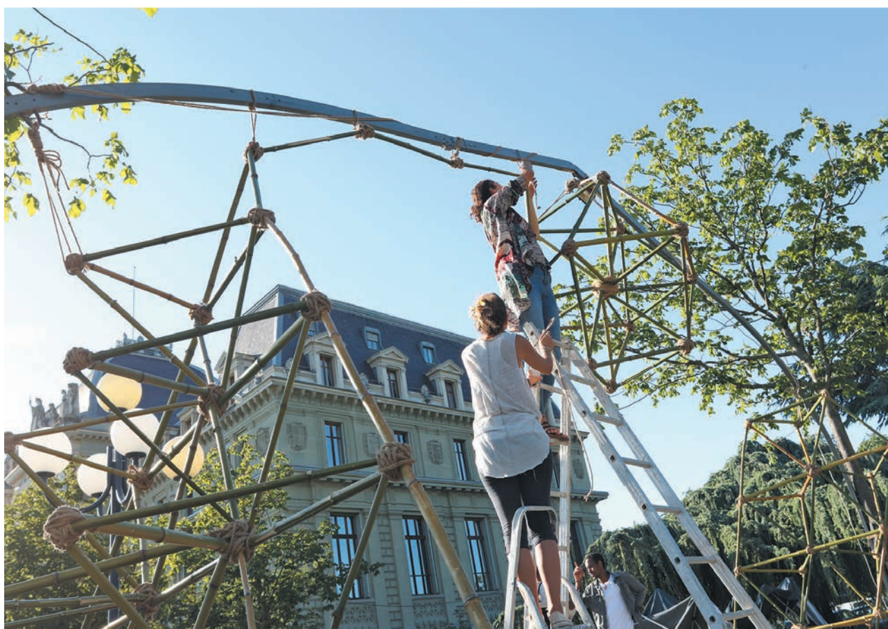
Structures réutilisables assemblées avec des cordes (Festival Objectif Terre de Lausanne)
